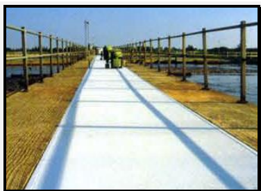
ZDJĘCIE 1 – panele pomostowe w ciągu komunikacyjnym
