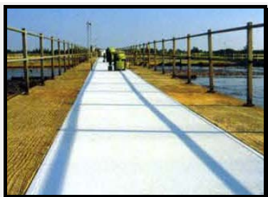
ZDJĘCIE 1 – panele pomostowe w ciągu komunikacyjnym
